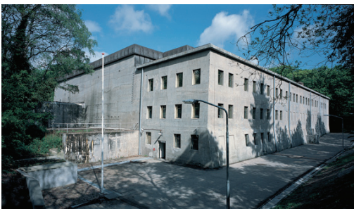
Figuur 3.2 Bunker Grossraumgefechtsstand Diogenes
