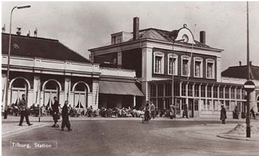
Figuur 4.1 Oorspronkelijk station Tilburg (1862-1965)
