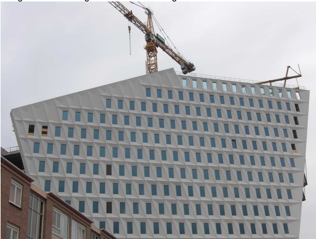
Figuur 7: stadskantoor Leyweg in aanbouw (2010)
