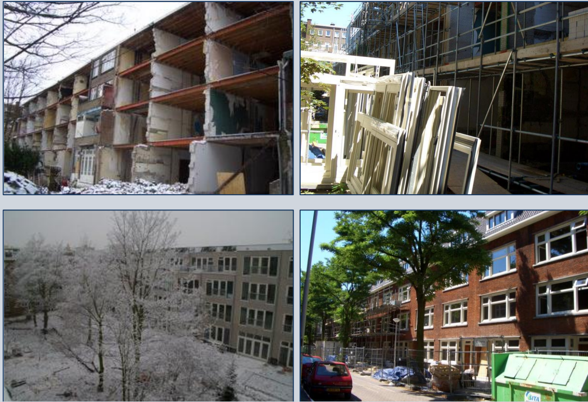
Figuur 17. Wallisblok in Rotterdam: achtergevels en voorgevels ( www.dedichterlijkevrijheid.nl )
