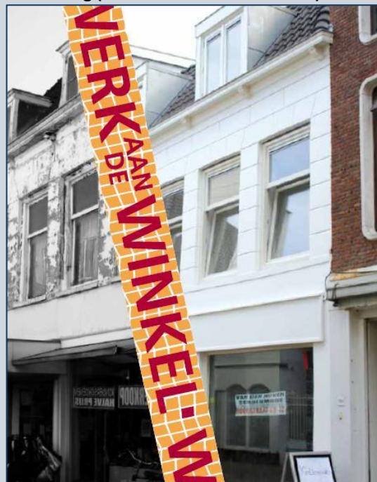
Figuur 10. Pand in centrumgebied voor en na verbetering (Gemeente Schiedam 2011b)
