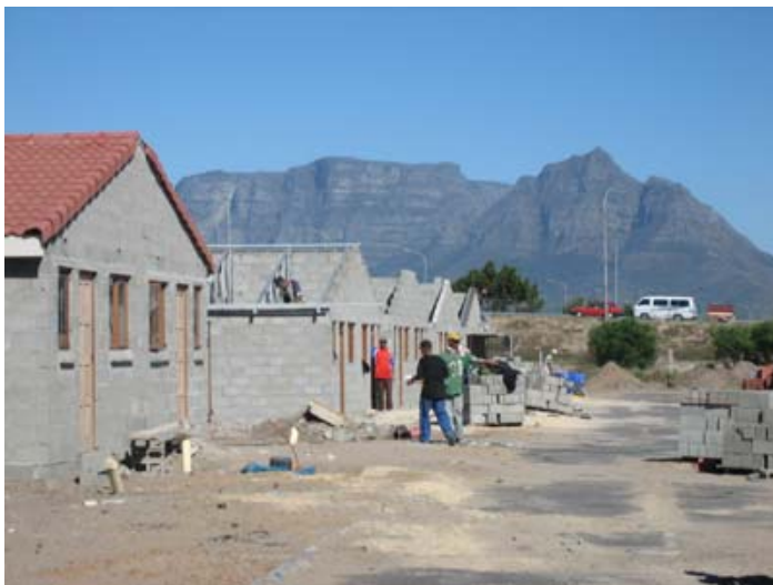
Afbeelding 7: Netreg projecthuizen in aanbouw
