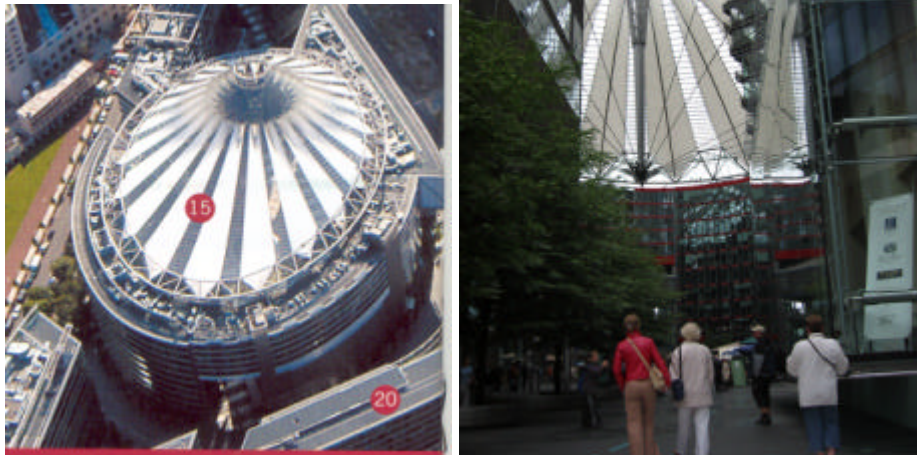
Bovenkant van het dak van delen tentdoek van de Sony Plaza Bron: Potsdamer Platz Journal Het dak van Sony Plaza vanaf maaiveld gezien Foto: Hoevenaar, 2005
