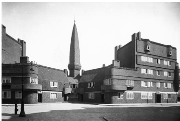
Het Schip, Spaarndammerbuurt (Amsterdam), 1919 voorbeeld van bouw volgens ideeën van de Amsterdamse School bron: Digitaal Museum van de Volkshuisvesting, Aedes Fotoarchief
