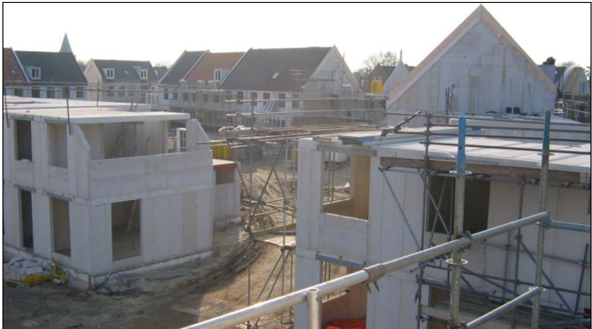
Figuur 10, Utrecht De Woerd, fase 1 in aanbouw
