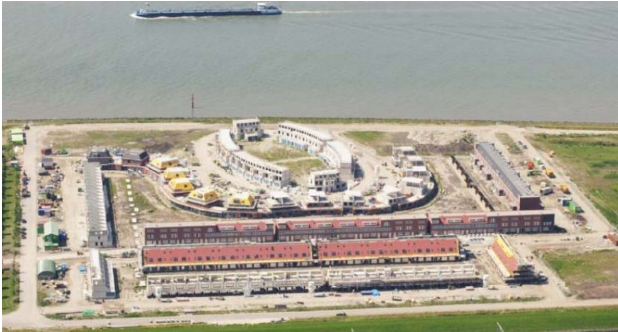
Figuur 7, Maassluis Het Balkon, fase 1 in aanbouw ( www.hetbalkonvanmaassluis.nl )
