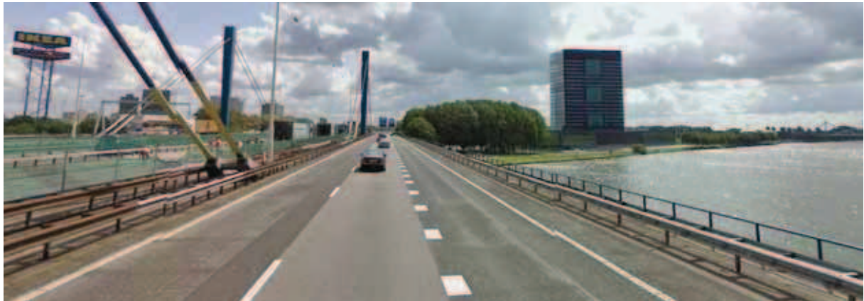
Amsterdam Rijnkanaal en A12, Galecopperbrug. Rijkswaterstaatgebouw (RWS) op Westraven.
