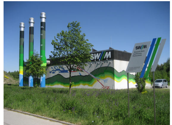
Afbeelding 2.12 Geothermie-anlage van SWM in München-Riem (Bron: GtV-Bundesverband Geothermie)
