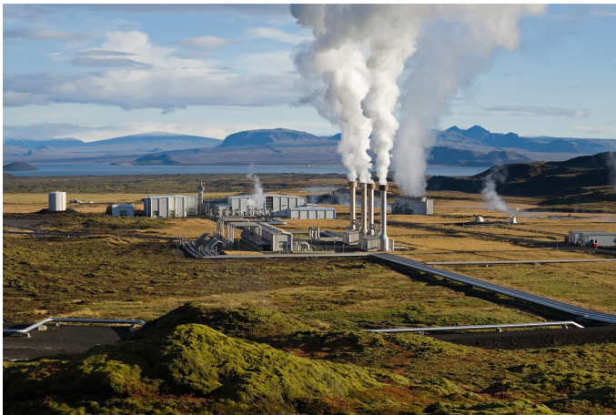
Afbeelding 2.11 Elektriciteits- en warmtecentrale in Nesjavellir, IJsland. (Bron: energienieuws.info)
