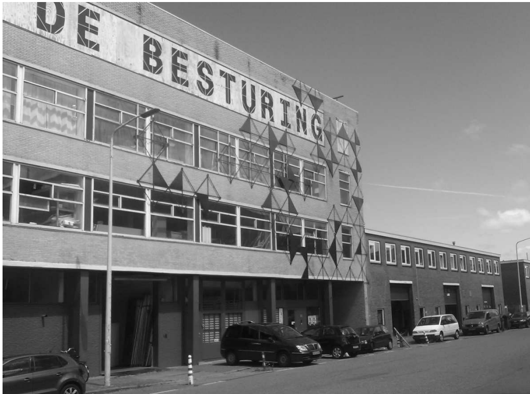
Figuur 3.8: Creatief ambachtelijk bedrijfsverzamelgebouw De Besturing
