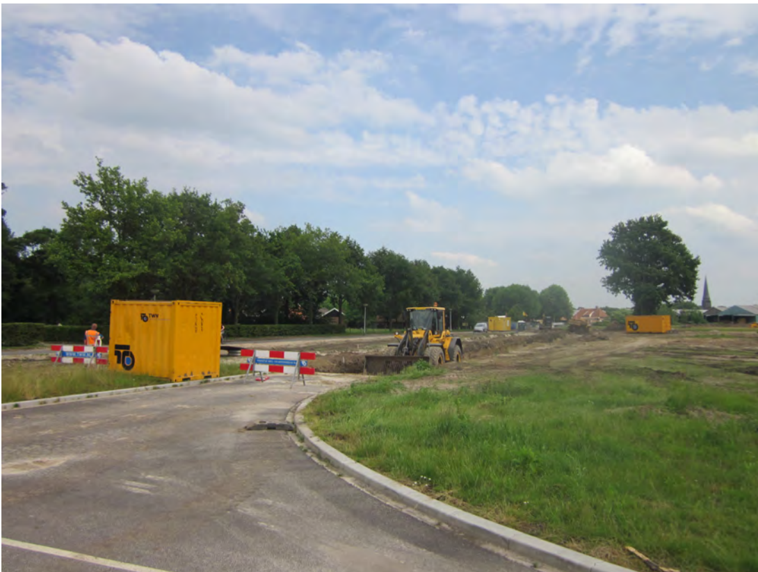
Figuur 33: De aanleg van de nieuwe verkeersstructuur langs de oostzijde van Indië vanaf de noordzijde gezien (juni 2014).
