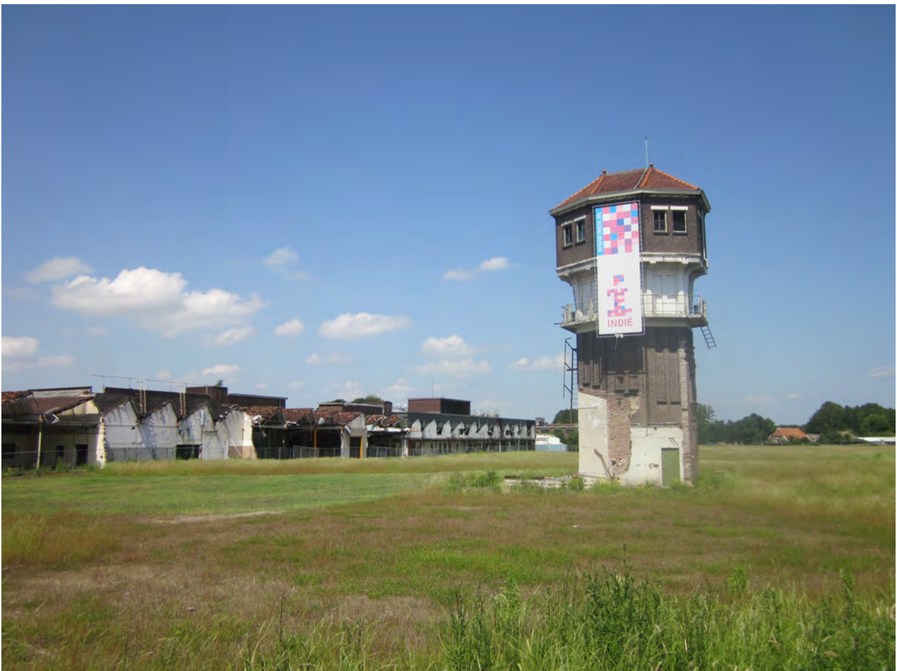
Figuur 26: De monumentale watertoren. Het risico op brand bij het productieproces was groot en in vroeger tijden kwam hier het bluswater voor de blusinstallaties vandaan. Op de achtergrond de karakteristieke sheddaken van de loodsen.
