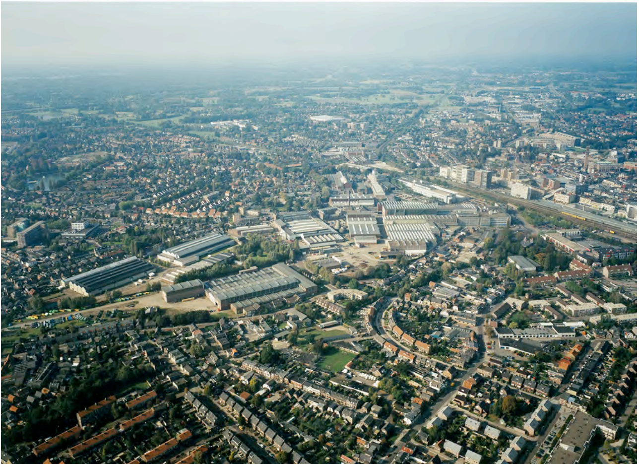
Figuur 41: Luchtfoto van het plangebied met in het midden goed zichtbaar de fabriekshallen van Stork en Dijkers. Bron: Van Wijnen Vastgoed.
