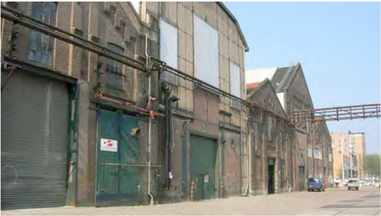
Figuur 5: De Van Gendthallen gezien vanaf de noordzijde.
