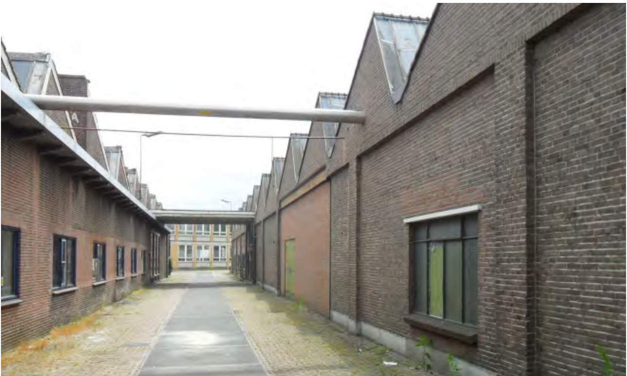
Figuur 25: De “Kalverstraat” met aan weerszijde de karakteristieke sheddaken die met hun steile zijde van glas voor daglicht zorgden in de hallen. Bron: KAW.
