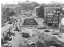
Cityvorming in Amsterdam, aanleg van de metro
