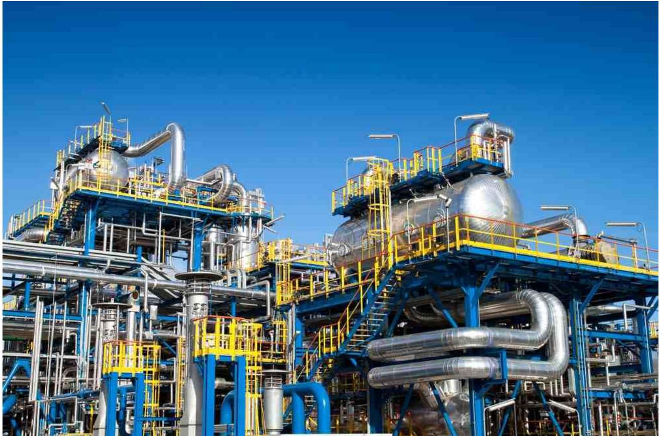
Afbeelding 5: Hoogwaardige installaties vragen vakkundig toezicht.
