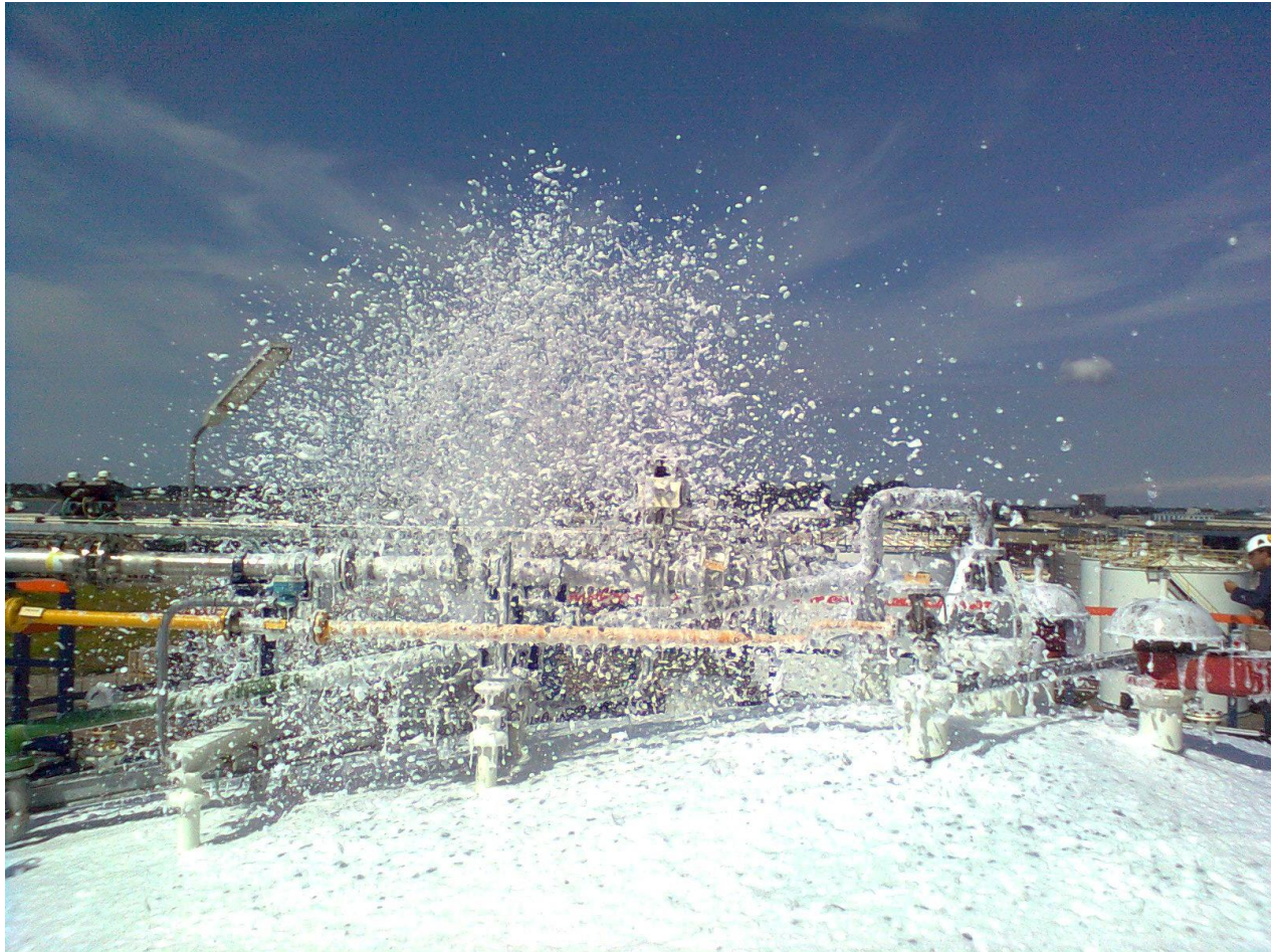
Afbeelding 4: Het aanbrengen van een schuimdeken op een chemicaliëntank nabij de dampverwerkingsinstallatie.
