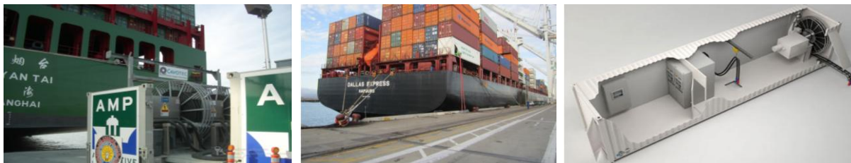
Figuur 2.11: Van links naar rechts, afbeelding 1: Toepassing van walstroom bij containerschip in de haven van Long Beach, California. (Bron: covatec.com), afbeelding 2 en 3: Walstroomcontainer ontwikkeld door Hapag-Lloyd en SAM Electronics (Bron: Maritimepropulsion.com).
