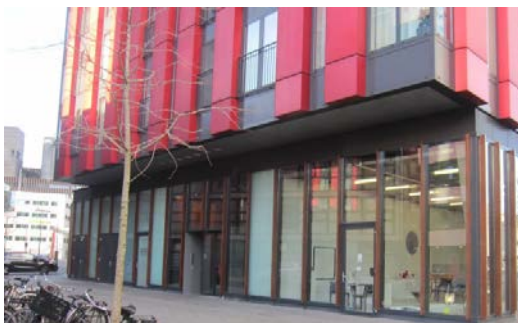
5 = zeer sterke verticaliteit door gebruik van uitste- kende delen, gebruik van lamellen en verspringing gevel (Red Apple, R'dam)
