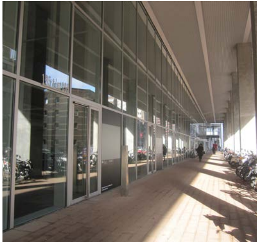
Foto's van (de plint van) De Rotterdam
