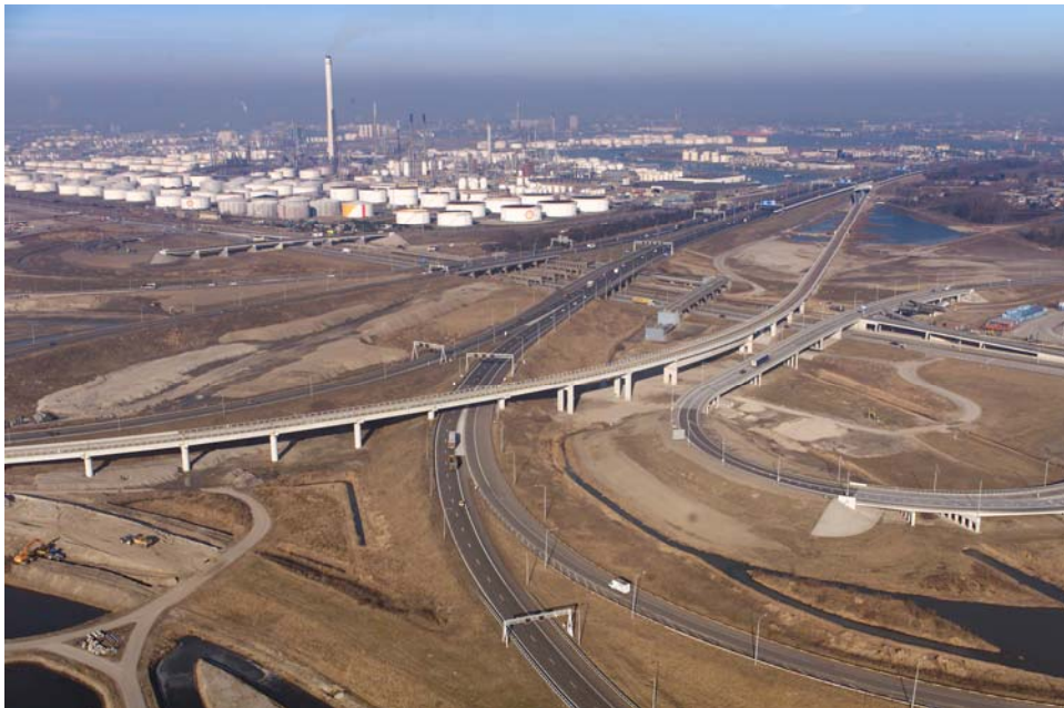
Foto 1: Infrastructurele werken in aanbouw bij deelgemeente Hoogvliet
