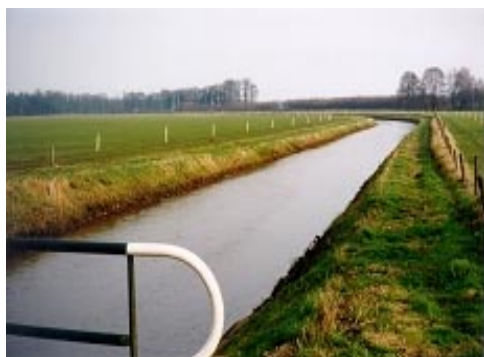
Oostrumsche beek eind jaren zestig: gekanaliseerd
