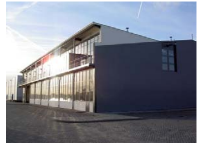
afb. 4: MADE: renovatie Keilestraat
