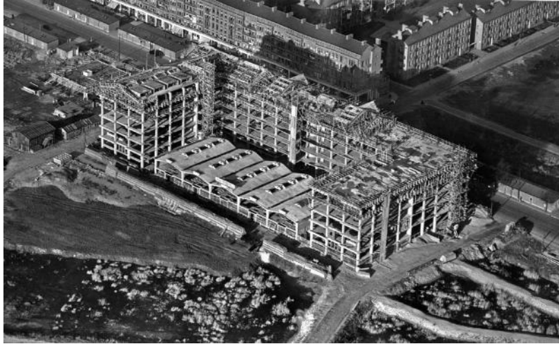
Figure 7-2. Het Industriegebouw under construction, September 1949. KLM.
