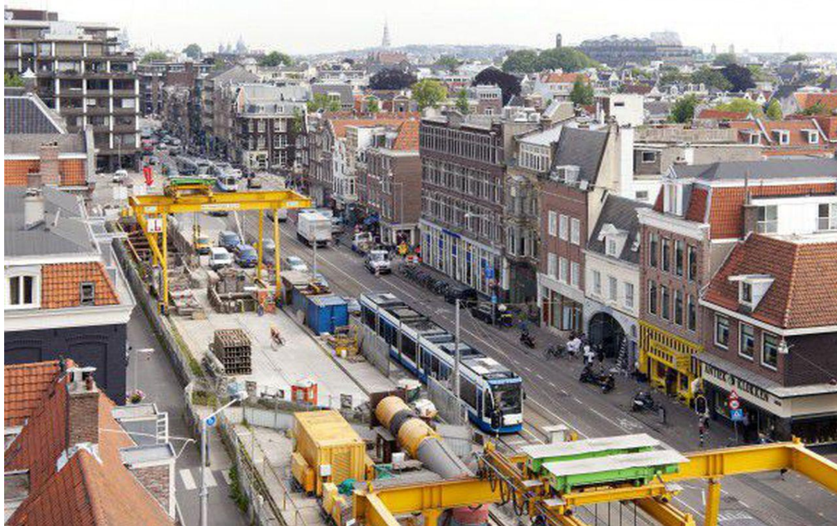
Figuur 4 Bouwwerkzaamheden ruwbouw Vijzelgrachtstation 2012 (NRC, 2012)
