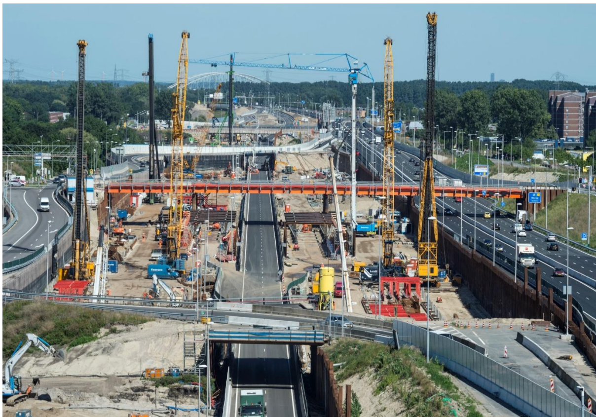
Figuur 7 Werkzaamheden ruwbouwfase tunnel
