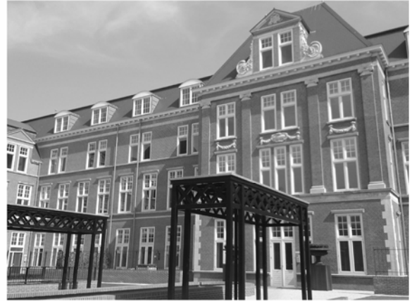
Weinig ouderdomswaarde: de onlangs gerenoveerde Magistraat in Rotterdam (van oorsprong uit 1913).
