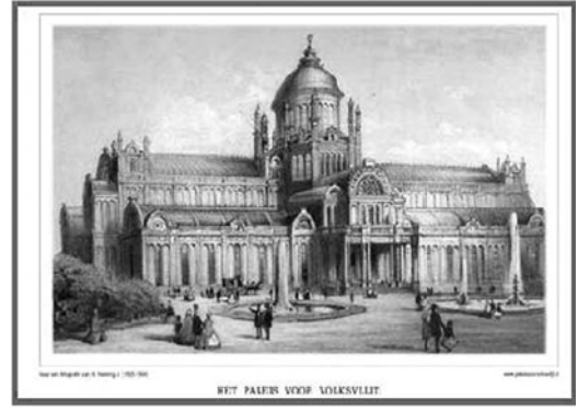
Ansichtkaart van het Paleis voor Volksvlijt, met zicht op de achterkant van het bouwwerk (en op het park) .
