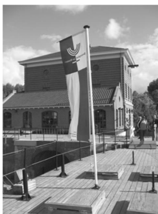
De reconstructie van het Pomphuis, gezien vanaf de schipdeur (westzijde).
