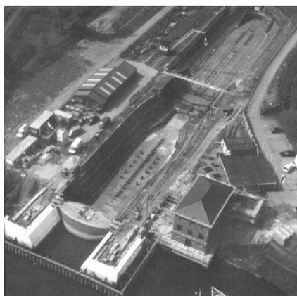
Het Droogdok Jan Blanken tijdens de restauratie. Rechtsonder de reconstructie van het Pomphuis (in uitvoering).
