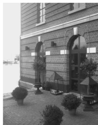
Het gereconstrueerde Pomphuis aan de entreezijde (oostzijde).
