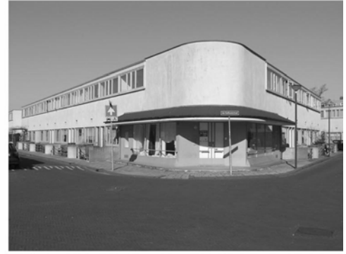
Eén van de twee afgeronde hoeken in De Kiefhoek, met op de begane grond winkelruimte.
