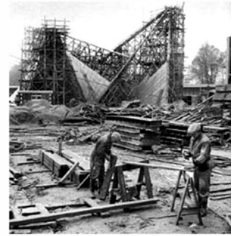
Het Philipspaviljoen in aanbouw (beton op een staalskelet).
