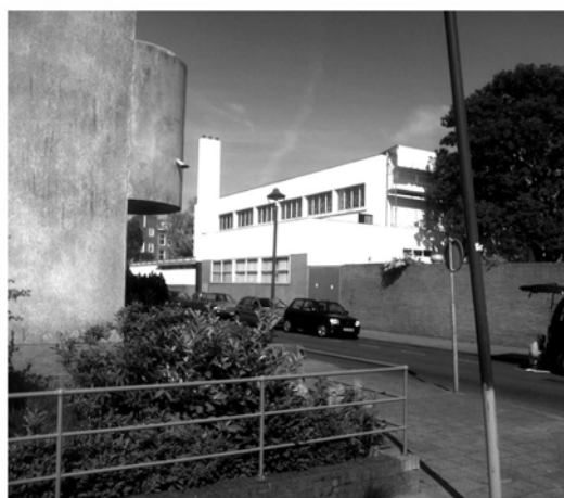
Links vervuild stucwerk in De Kiefhoek. Op de achtergrond het onlangs opgeknapte kerkgebouw.
