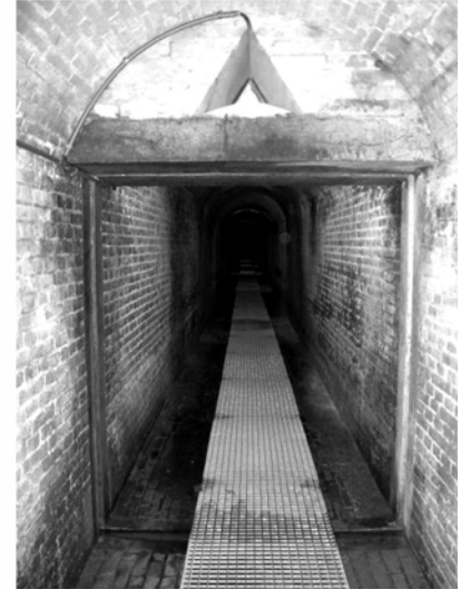
Het gangenstelsel van het aquaduct rondom het Droogdok Jan Blanken.
