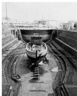
Schip in leeggepompt Kieldok van Droogdok Jan Blanken (vóór restauratie).
