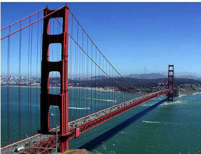
Golden Gate Bridge, Joseph B. Strauss, San Francisco, 1937. Een van de bekendste bruggen ter wereld. Het heeft tot op heden geen concurrentie gekregen van een moderne brug. Een mogelijke reden is dat er niet veel technische mogelijkheden zijn om een brug te maken, die er heel anders uitziet dan bruggen met een conventionele draagconstructie. Verder is het spectaculaire uitzicht van de Golden Gate Bridge moeilijk te overtreffen.
