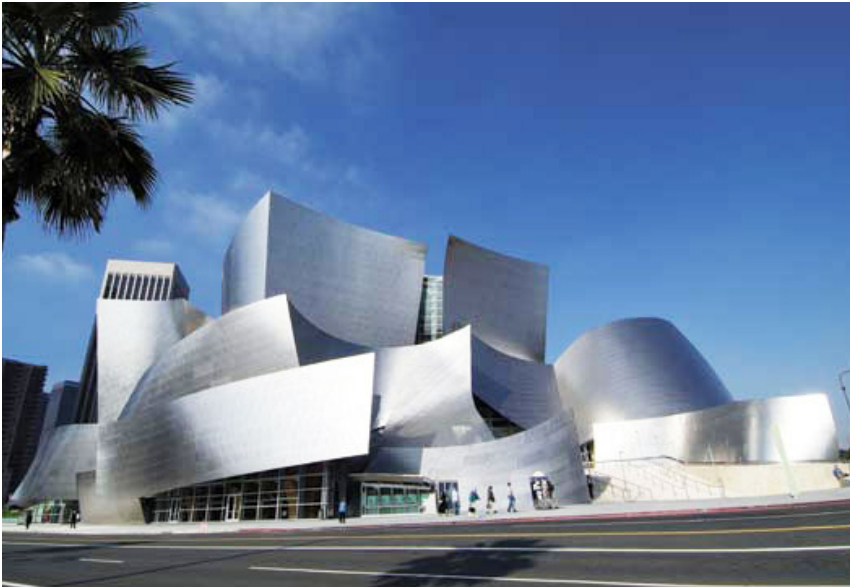
Walt Disney Concert Hall, Frank O. Gehry, Los Angeles, 2003. Een van de weinige landmarks in L.A. Het heeft dezelfde kenmerkende vormen en materialen als van andere gebouwen van de architect. In 1988 won Gehry de competitie voor deze concerthal, maar door tegenslagen, zoals recessies in de jaren negentig, heeft de constructie vijftien jaar geduurd. (Jencks, 2005:173) Misschien had deze landmark anders, in plaats van het Guggenheim Bilbao, de voorbeeldfunctie gekregen.
