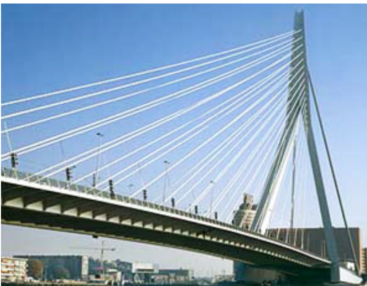
De Erasmusbrug, Ben van Berkel, Rotterdam, 1996. Voor Rotterdam is deze brug, die ook wel de Zwaan wordt genoemd, het stedelijke icoon. Op mondiaal niveau is de brug onbekend. Zelfs spectaculaire (sport)evenementen hebben hier geen verandering in kunnen brengen.
