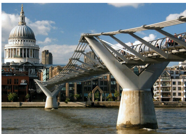
Millennium Bridge, Norman Foster, Londen, 2000. Deze voetgangersbrug is een van de bouwwerken van Londen die sinds het begin van deze eeuw door sterarchitecten worden gemaakt. Op de achtergrond staat de St. Paul's Cathedral.
