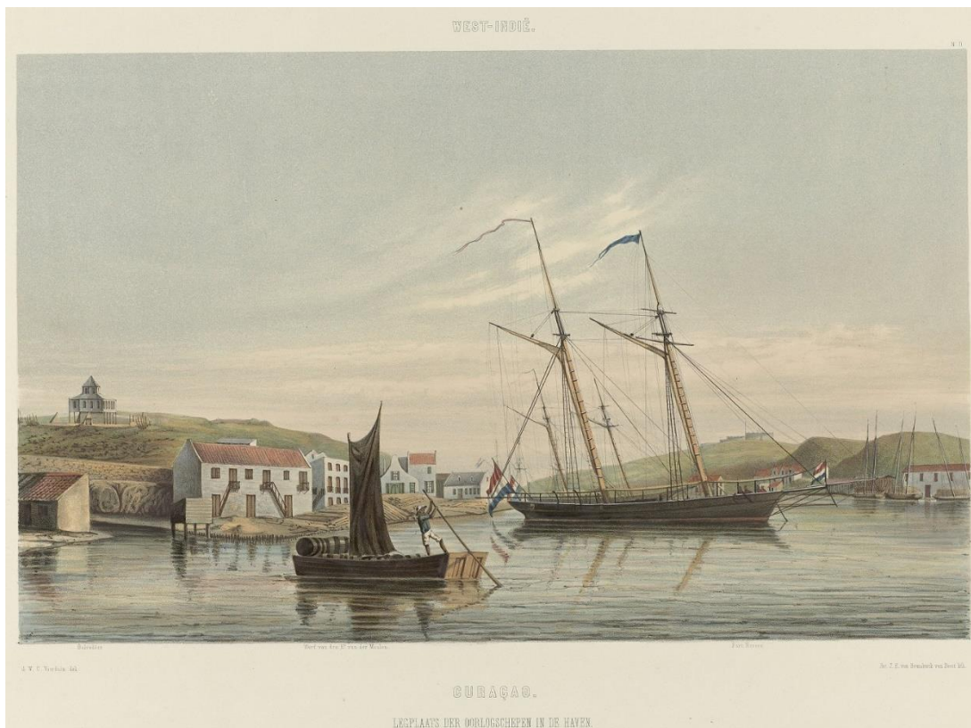
AFB. 4.3 PRENT (PLAAT XI), AANLEGPLAATS IN DE HAVEN VAN WILLEMSTAD, CURAÇAO. GERARD VOORDUIN EN JACOB EDUARD VAN HEEMSKERCK VAN BEEST, 1860-1862
