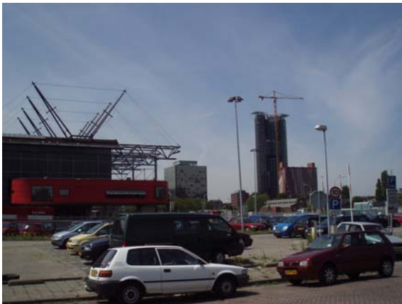
'Het Strijkijzer' (Rijswijkseplein) in aanbouw
