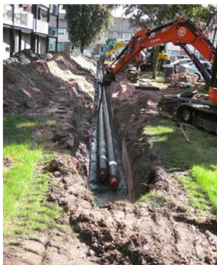
Foto 5.1: aanleg warmtenet Pijnacker
