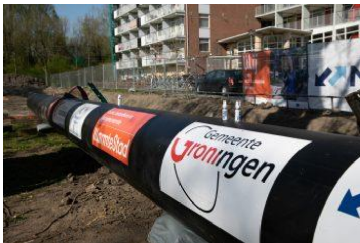
Foto 5.2: aanleg warmtenet Groningen
