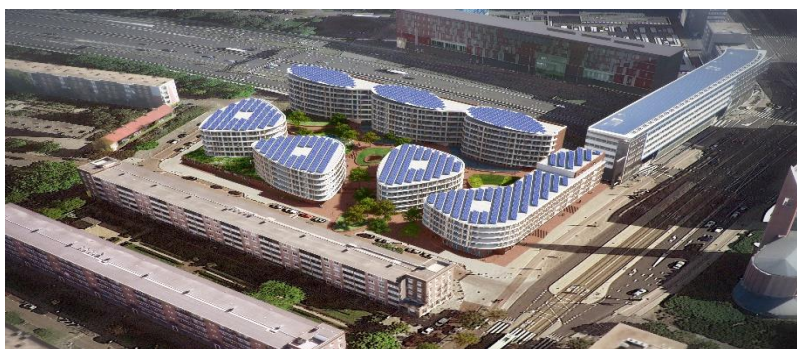
Figuur 6 Rhapsody gebouw Kolenkitbuurt. Huren in Rhapsody, 2019
