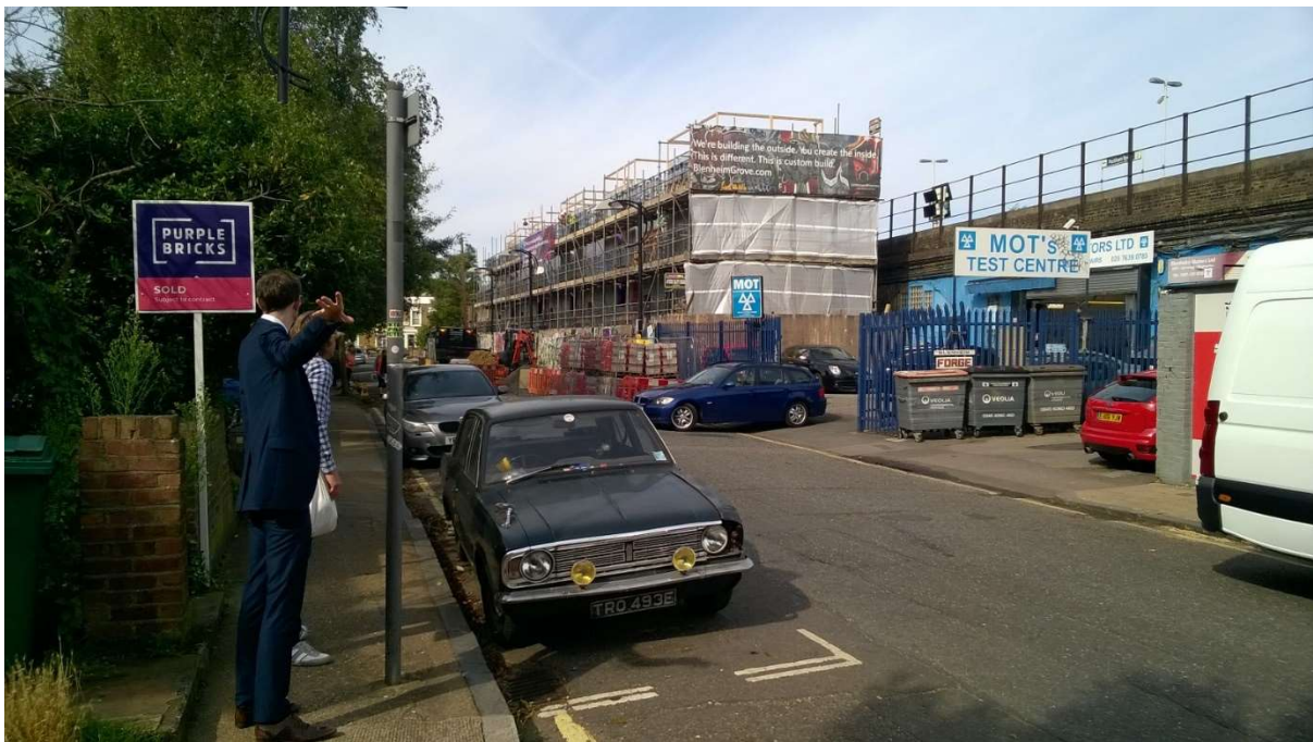
Foto 6 De casco's van Blenheim Grove in aanbouw
