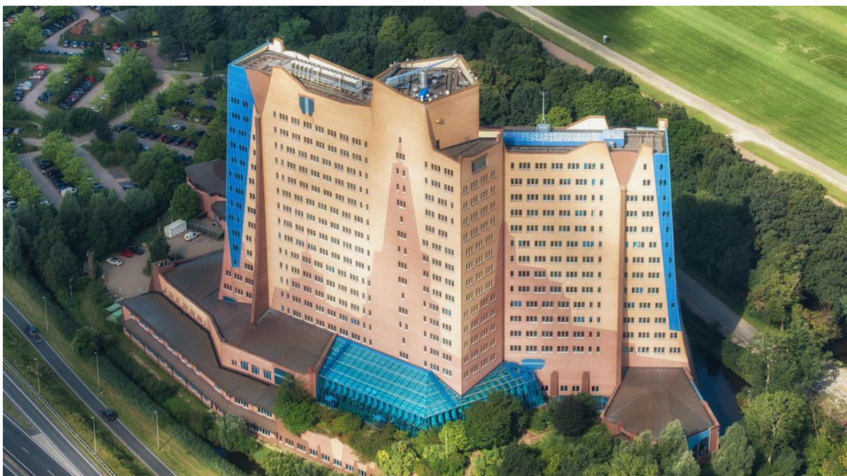
Figure 4.16 Gasuniegebouw in Groningen (HollandLuchtfoto, n.d.)
