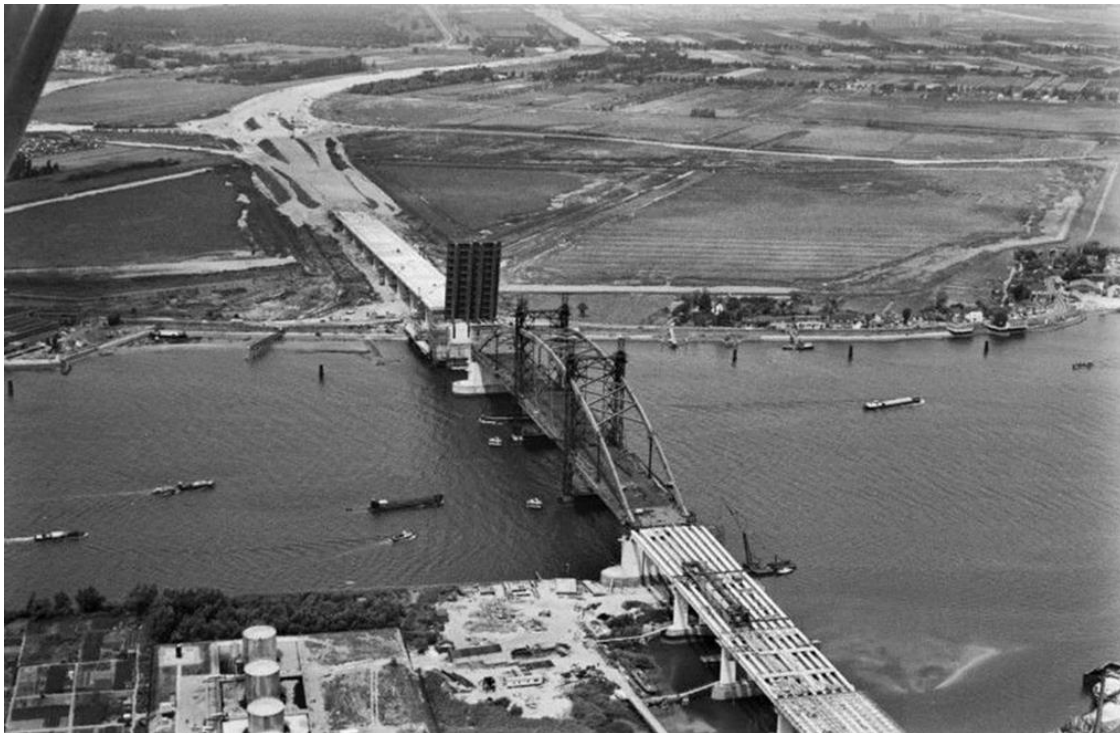
Figuur 10 Bouw van de Van Brienenoordbrug in de jaren '60
