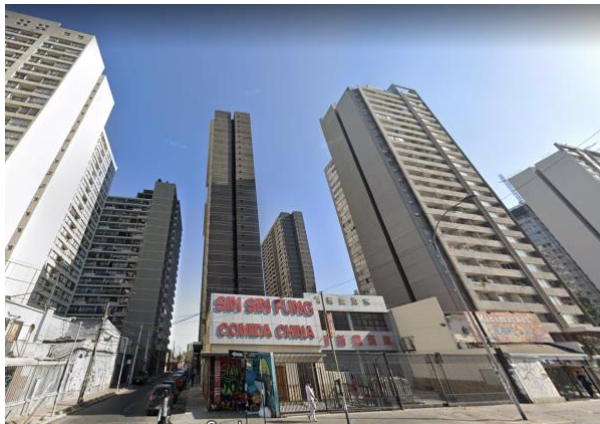
Image 5 Estación Central - Multistorey building.
