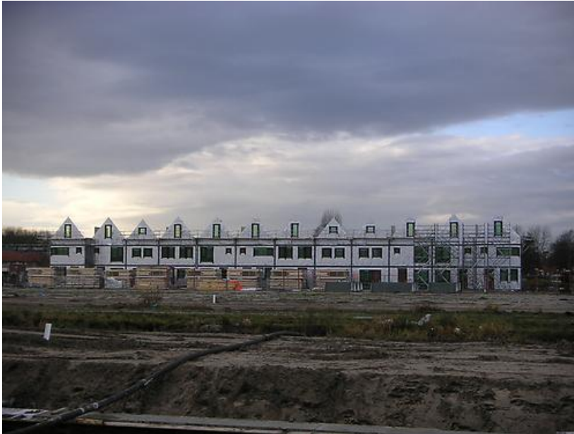
Maasdijk, Breda in aanbouw
