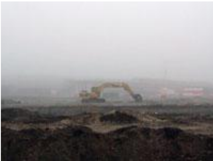
Eiland 6, Utrecht in aanbouw
