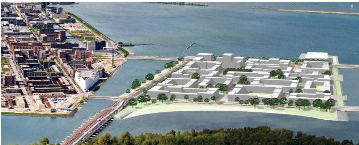
Figuur 8: Overzicht Centrumeiland (Amsterdam, 2016)
