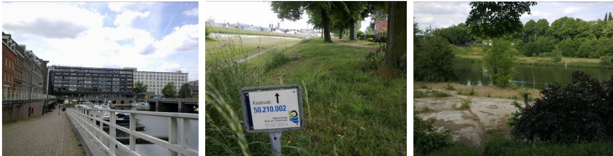
Figuur 4.6 Foto's van Belvédère, Maastricht: (links) Bassin, (midden) waterkering nabij Maas, (rechts) Jojobaven
